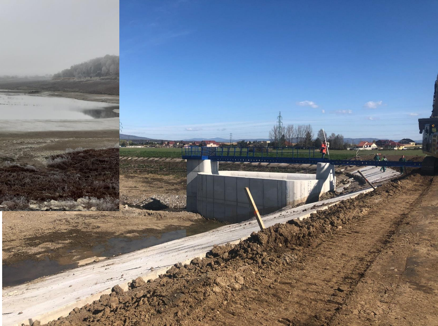
VS Ľadovo rekonštrukcia bezpečnostného prepadu
