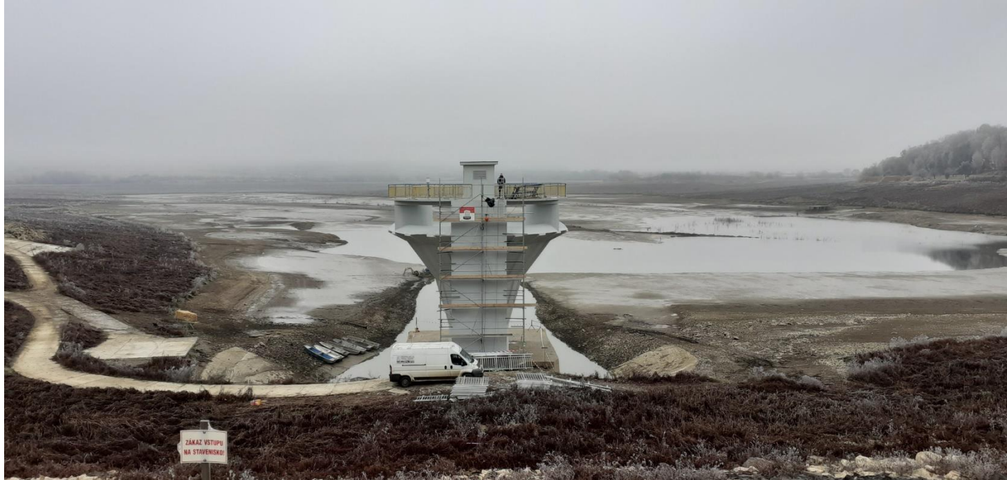
VS Ružiná rekonštrukcia bezpečnostného prepadu
